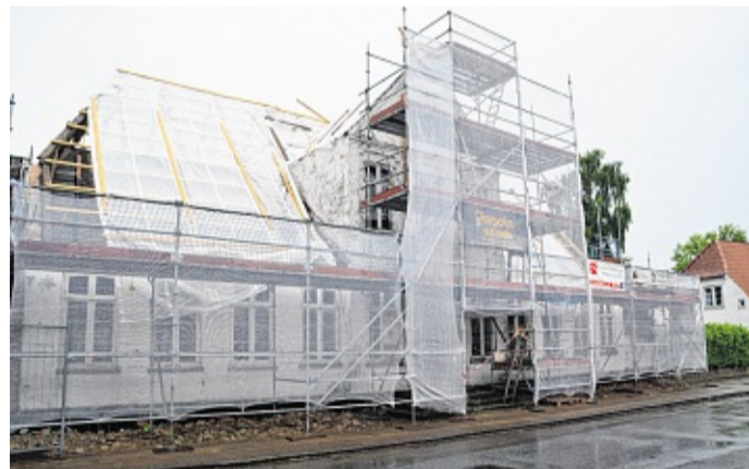
Das historische Haus des Hofrates erhält in erster Renovierungsrunde ein neues Dach. FOTO: DN-ARCHIV
