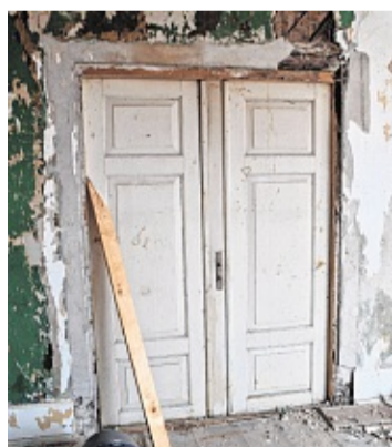
Auch diese Tür soll bewahrt werden.
